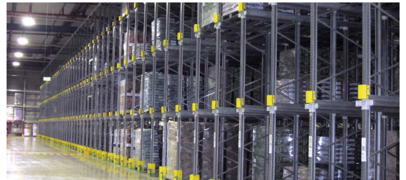
Einfahrregale für die platzsparende Lagerung bei entsprechender Artikel-/Kommissionierstruktur.
