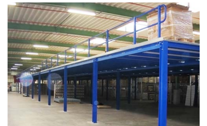
Verdopplung der Lagerkapazitäten erzielt durch eine zweite Ebene.
